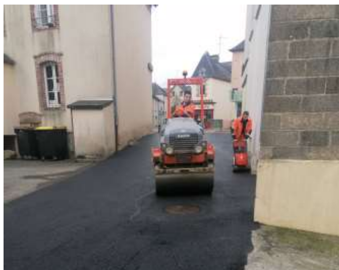
▲ Dernier chantier de réfection de la voirie de l'année 2021, Rue des Sertes.
