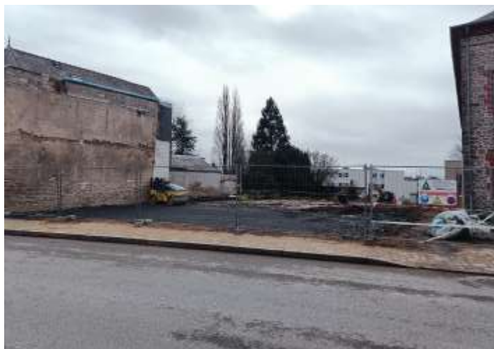
▲ Rue Philippe Lemerrier, après la démolition de l'ancienne maison notariale. La pharmacie viendra s'installer à cet emplacement.
