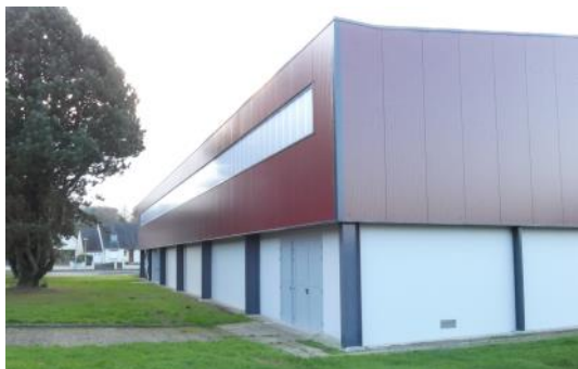
▲ Une nouvelle apparence et une meilleure isolation pour le gymnase.
